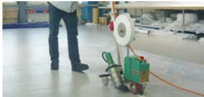
Soldadura de bandas a máxima velocidad.
